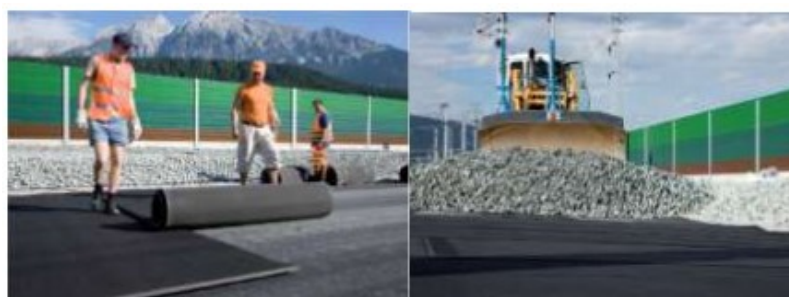
Illustrations de la mise en place de tapis sous ballast
