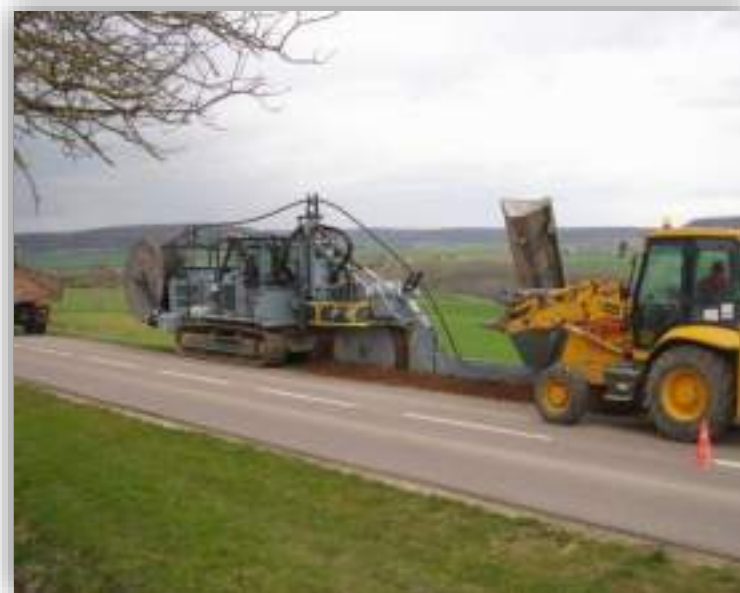
Réalisation d'une tranchée d'enfouissement des câbles de raccordement au réseau public de distribution d'électricité
