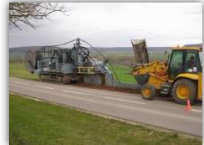
Réalisation d'une tranchée d'enfouissement des câbles de raccordement au réseau public de distribution d'électricité
