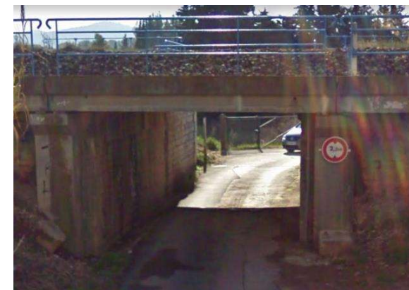
Figure 5 : vue du pont-rail depuis le chemin Les Maisons-Neuves (Systra, 2021)
