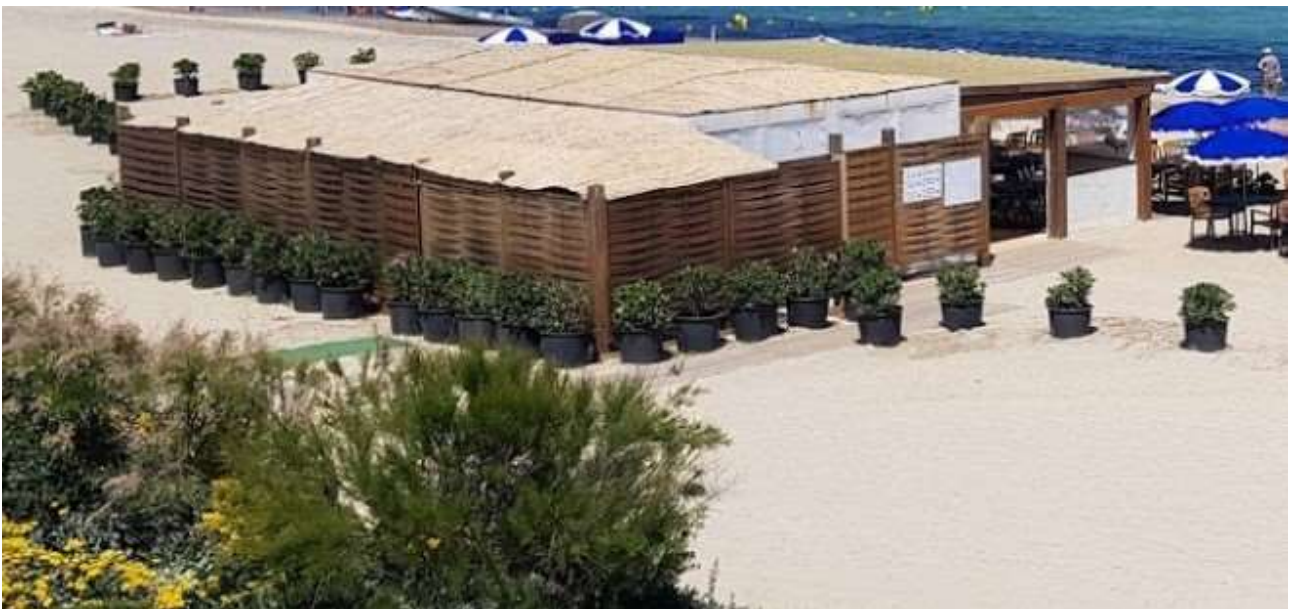
Figure 10 - Photographies illustrant les aménagements PMR (tapis en géotextile) pour l'accès à l'établissement au droit du lot n°2 (hors périmètre concédé)
