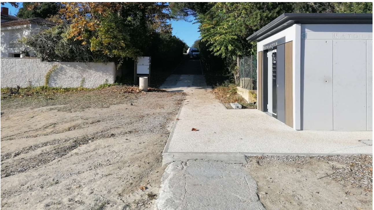
Figure 3 - Photos de la rampe d'accès au Parcours Cyclable du Littoral, depuis l'épi
