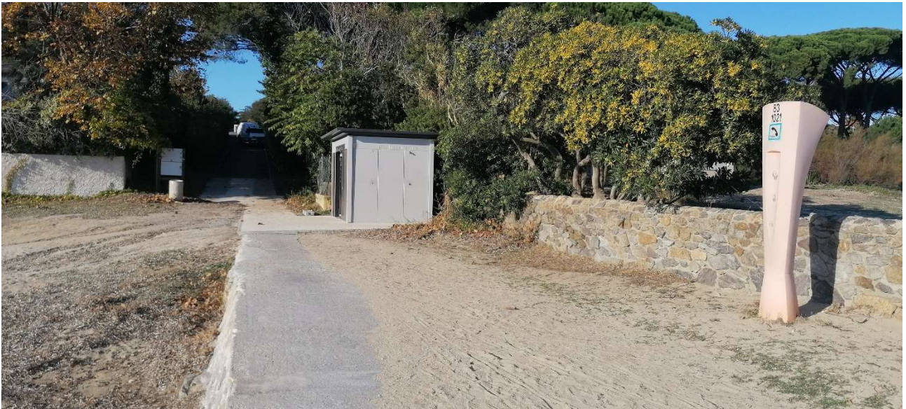
Figure 1 - Borne d'appel automatique GSM entre les plages du Vieux Moulin et de Beauvallon
