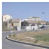
Habitat individuel de type lotissement pavillonnaire
