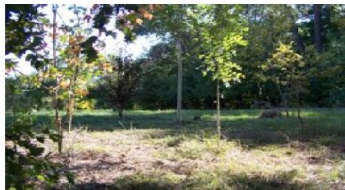
Illustration 16: La mise en œuvre du débroussaillage (source : DDT24)
