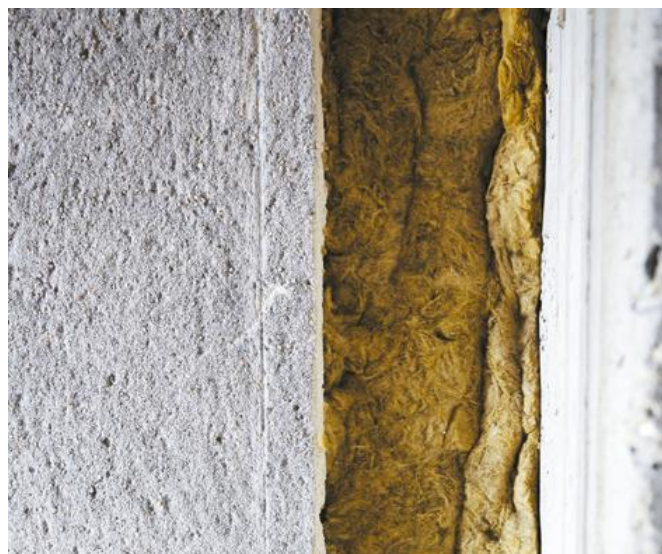
Les laines minérales sont performantes pour isoler la cloison du bruit et du froid.
