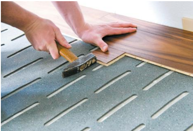
Poser une sous-couche acoustique permet d'atténuer au maximum la propagation du bruit vers les pièces du dessous.
