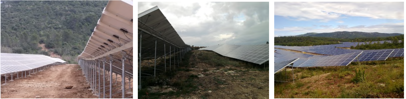
Reprise de la végétation dans l'année qui suit le chantier
