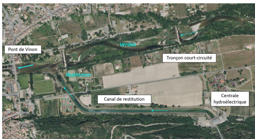
Figure 3 : Localisation des installations d'hydroélectriques et du réseau hydrographique au droit du Verdon à Vinon-sur-Verdon
