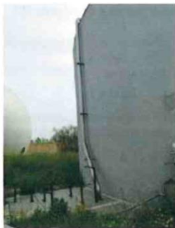
Photo 8 : Canalisation aérienne en sortie du digesteur
