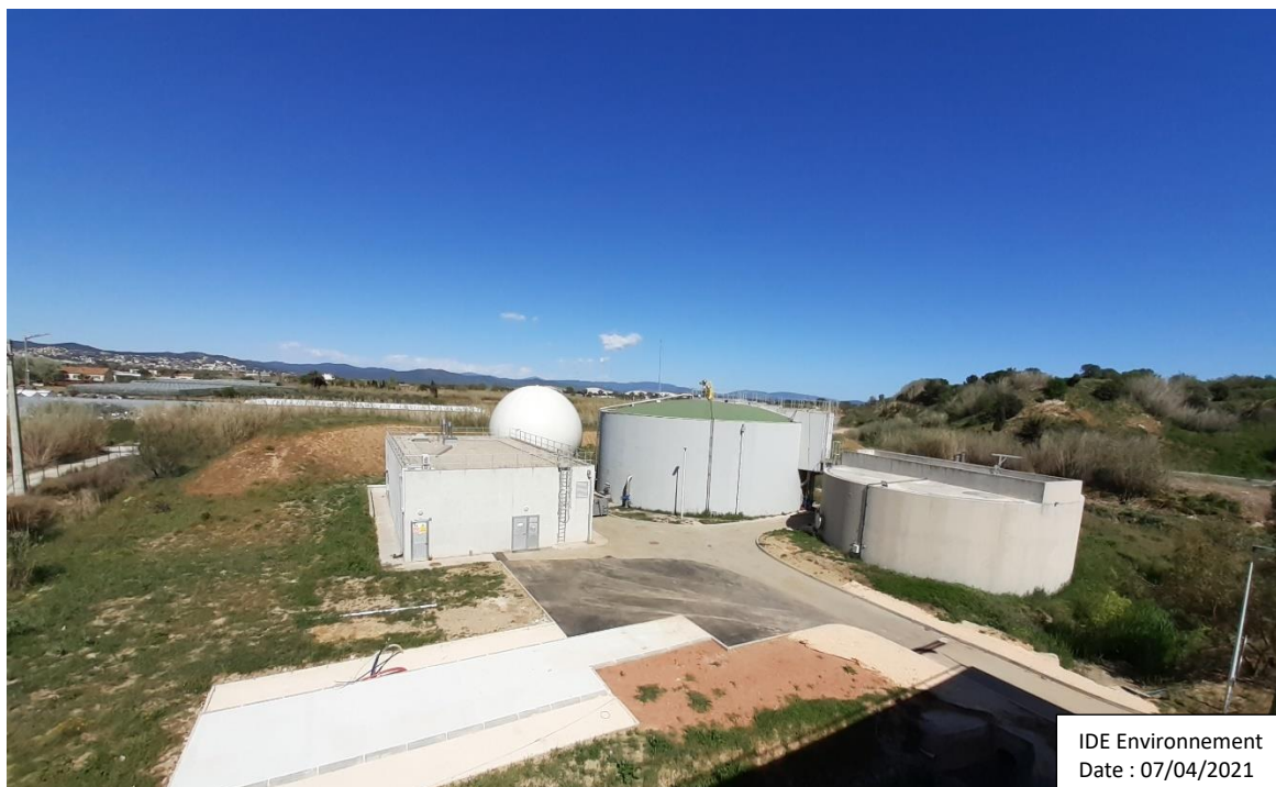
Photo 2 : Vue d'ensemble sur l'unité de méthanisation
