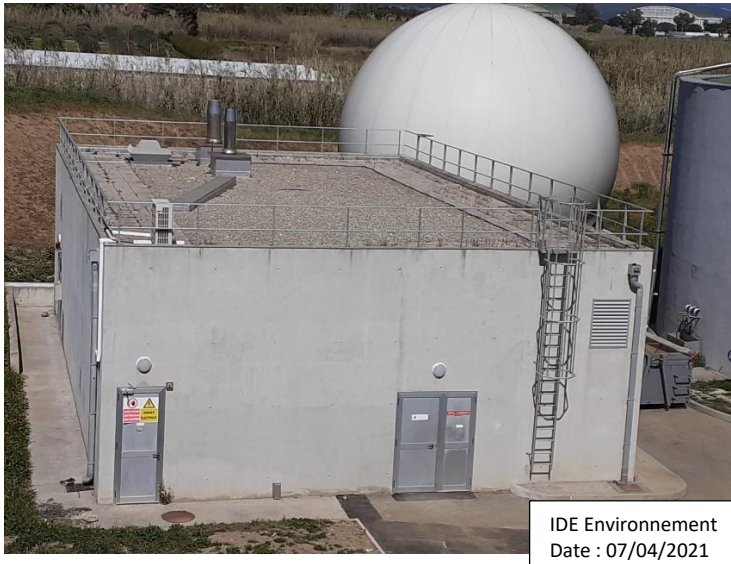
Photo 7 : Local technique et gazomètre
