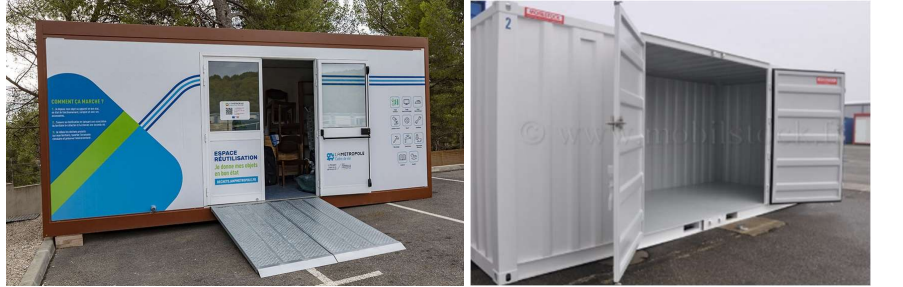
Cet espace se trouvera à l'entrée du site de manière à être dissocié du reste de la déchetterie.
