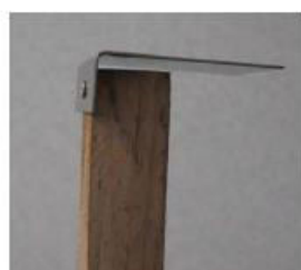
Maintien par vis de fixation
