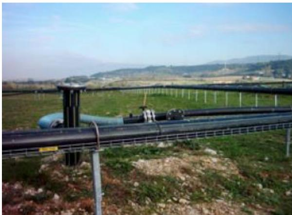
Figure 21. Photographie d'un réseau de captage de biogaz
