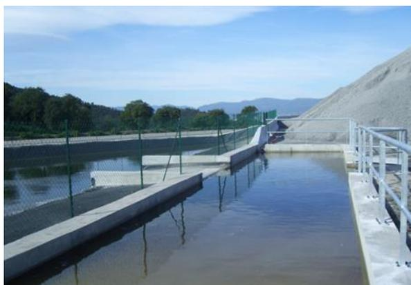
Les eaux résiduaires collectées par le bassin peuvent être reprises afin d'être utilisées sur la plate-forme de mâchefers étanche pour :
