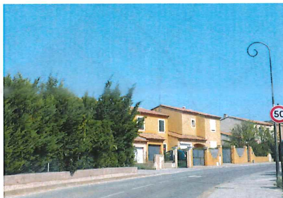
Urbanisme pavillonnaire à l'ouest de l'avenue Commandant Lofi (© Gomez)
