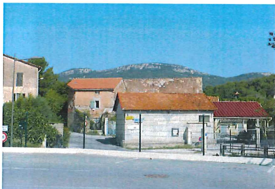
Les bâtiments d'un ancien moulin au nord du cimetière (© Gomez)
