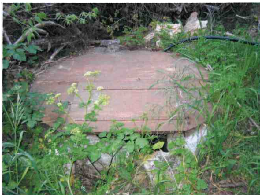
Puits à fermer
