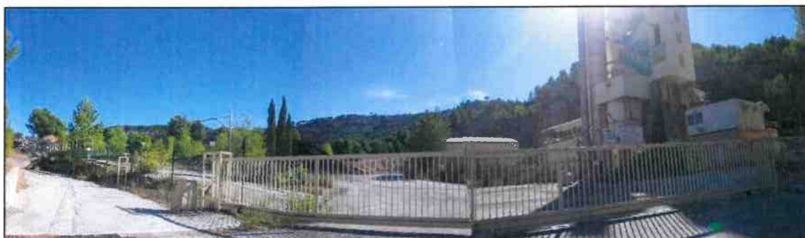
Figure 11: photographie du site "Toulon enrobés Evenos"
