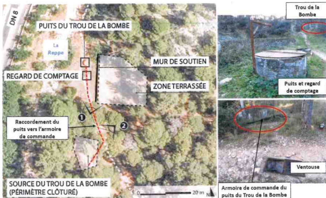
Figure 3 : Conditions de raccordement à l'armoire de commande électrique du puits du trou de la Bombe (Source : mairie d'Ollioules)
