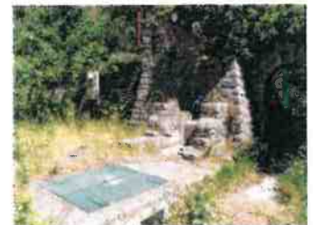
Regard de répartition extérieur
