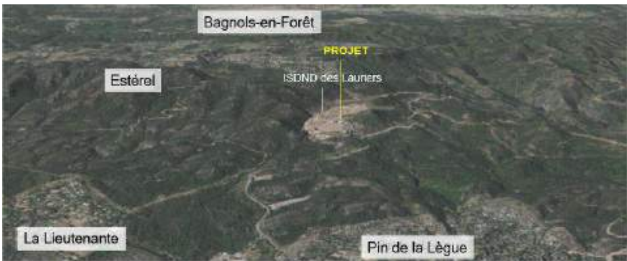
Vu 3D de la zone du site des Lauriers avec une orientation vers le nord. Source : Olentica (Mars 2020).
