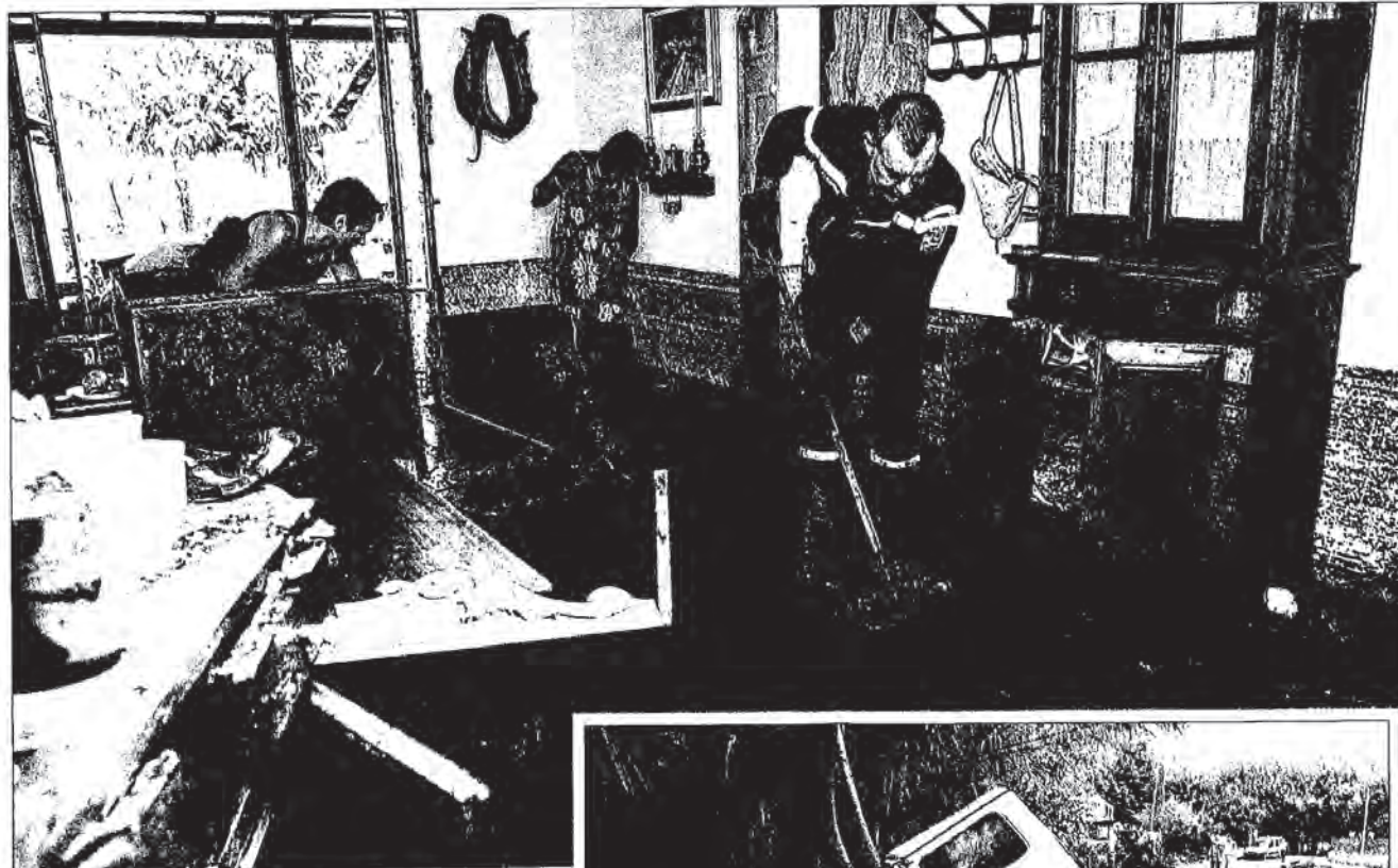
Dans de nombreuses habitations, l'eau est montée jusqu'à un mètre de hauteur.
