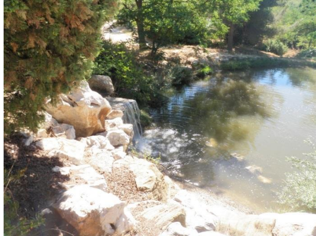
Figure 7 : Rejet des eaux de nettoyages issues de la station de potabilisation d'Hugueneuve
