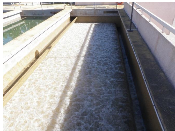
Etape de nettoyage / décolmatage des filtres
