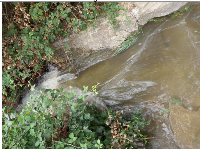
Vue du seuil entre le 2 ème et 3 ème bassin (aperçu du débit pendant le fonctionnement du cycle de lavage des filtres)
