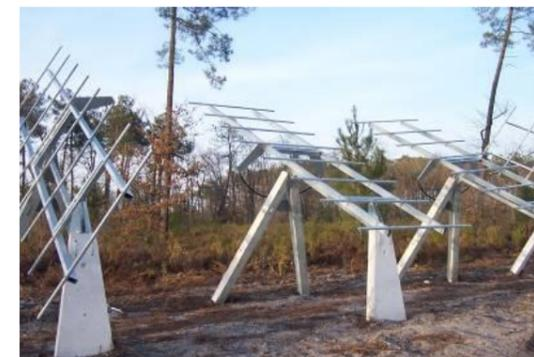
Photographie 17 : Montage des supports de la technologie « trackers »
