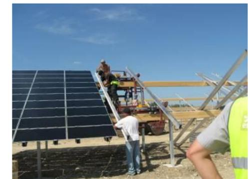
Photographie 18 : Montage de modules sur des supports fixes
