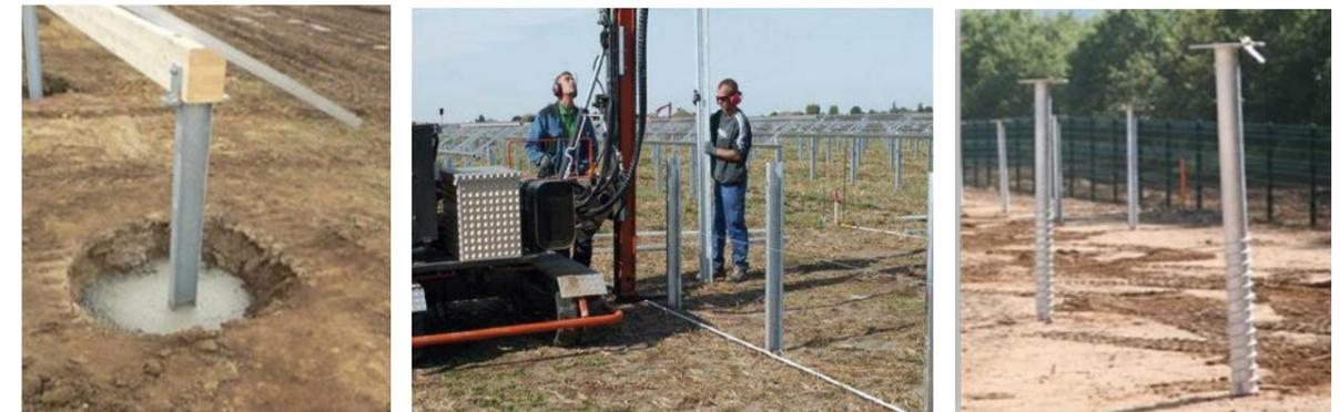
Photographie 16 : Fondation béton (gauche), fondation pieux battus (centre), fondation à vis (droite)
