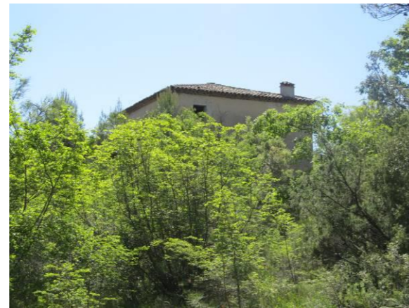
Photographie 36 : Habitation en ruine au sud-ouest de la zone d'étude immédiate
