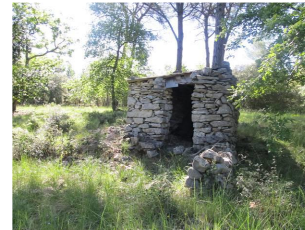
Photographie 42 : Occupation bâtie agricole au nord-est de la zone d'étude immédiate
