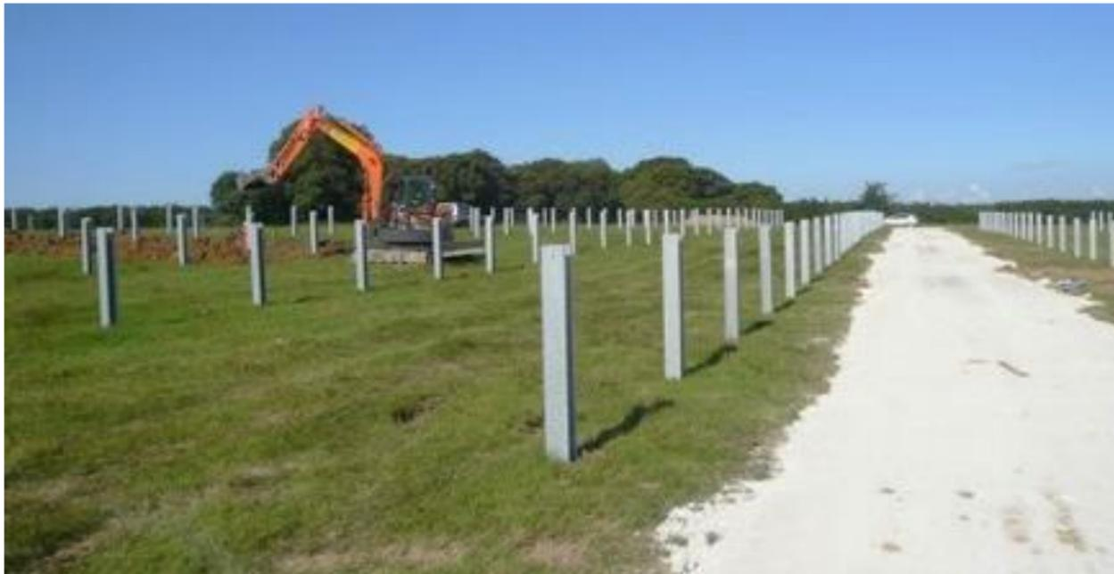
Figure 5: Travaux de montage des supports des modules. Source : ECTARE
