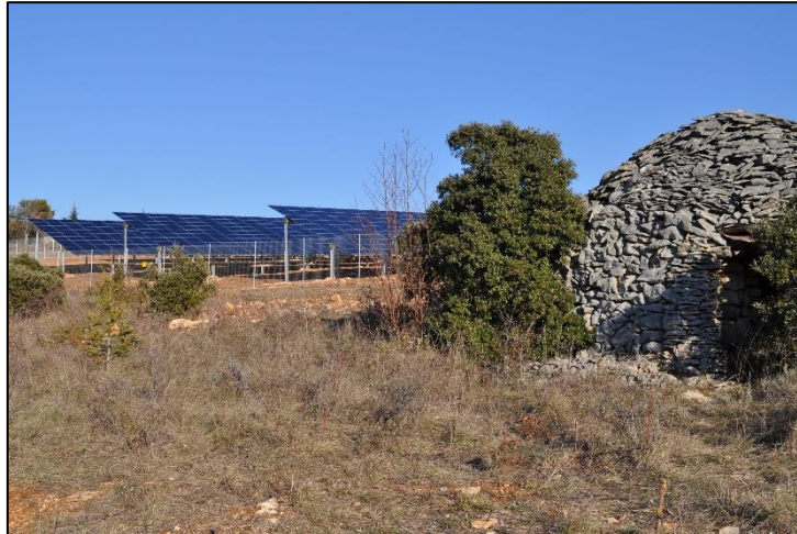
Centrale photovoltaïque de Blauvac
