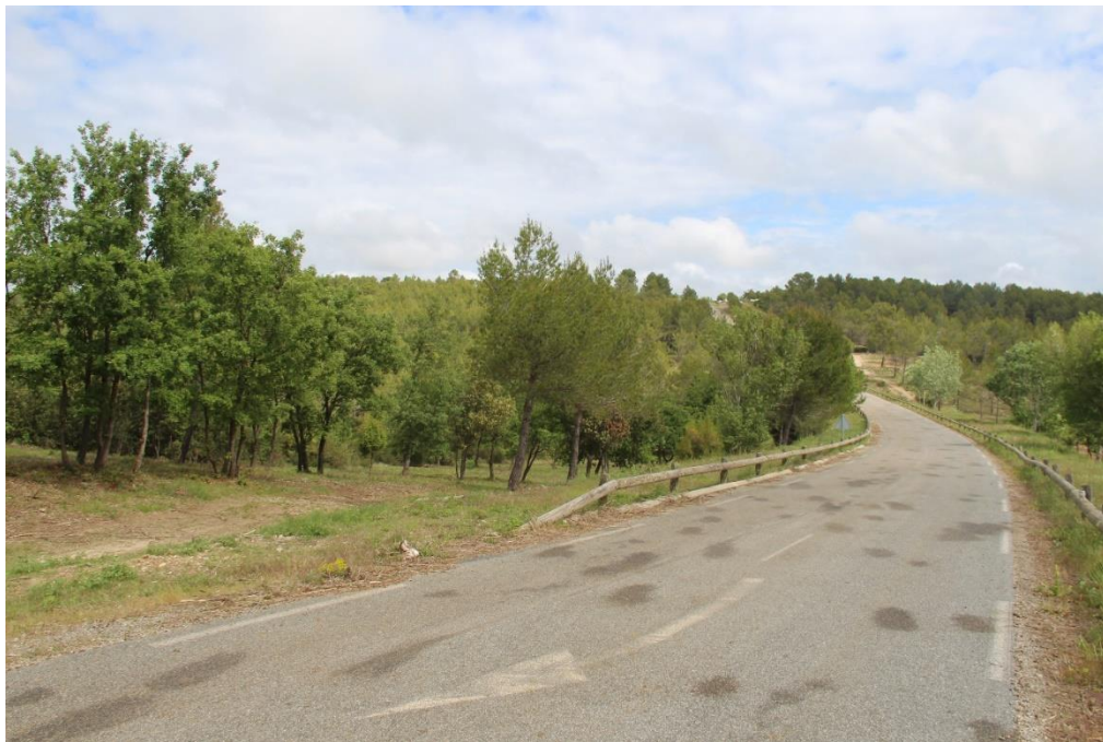
Figure 15: route amenant au futur site de la centrale photovoltaïque
