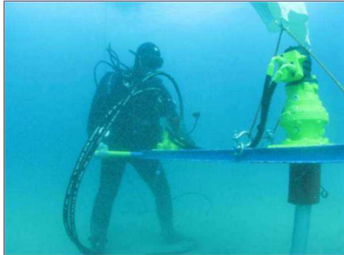
Figure 22. Mise en œuvre des ancres au moyen d'une clé hydraulique
