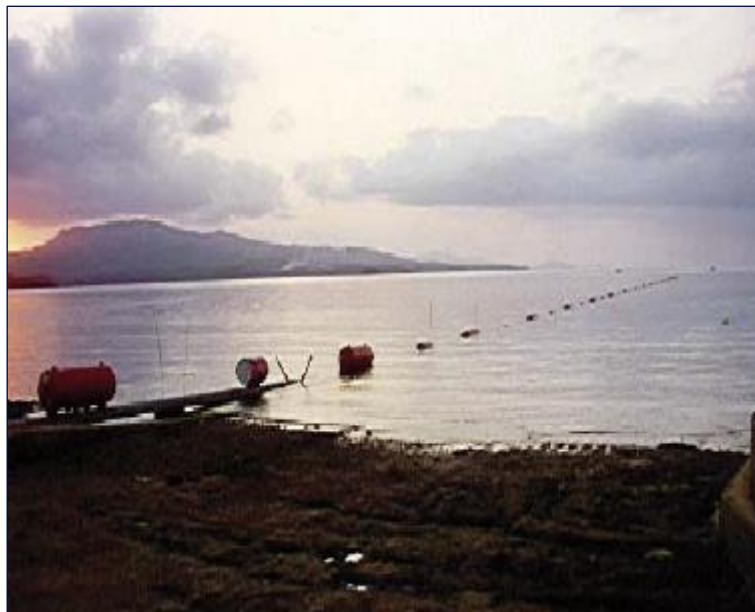
Figure 21. Bouées lors de l'immersion de la canalisation
