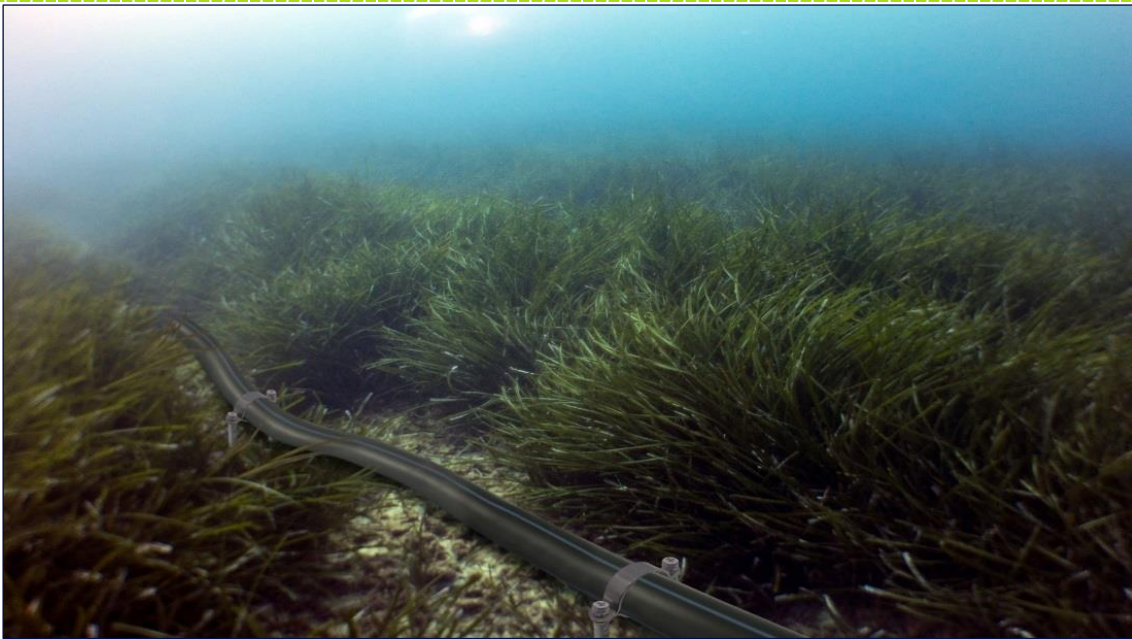
Figure 14. Illustration d'une conduite ancrée sur le fond
