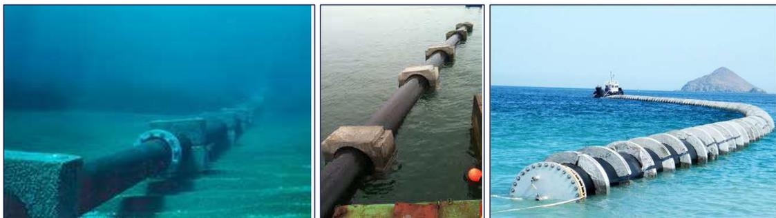
Figure 22. Exemples de conduites lestées avec des cavaliers béton
