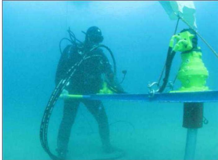
Figure 33. Mise en œuvre des ancres au moyen d'une clé hydraulique
