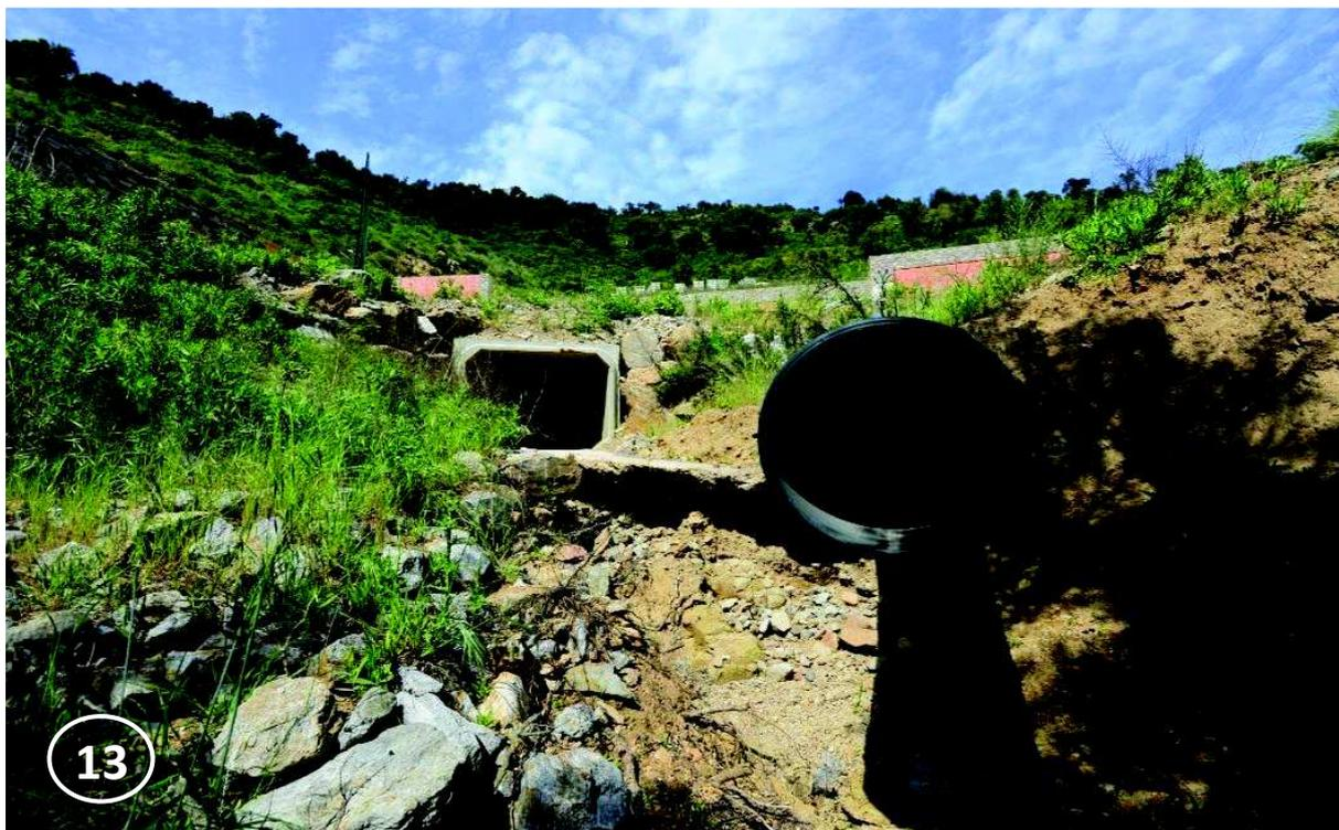
Figure 30 – Arrivée des écoulements de la Suane au droit du projet (sortie du cadre) et des eaux pluviales (buse) (Améten – 25/06/2015)
