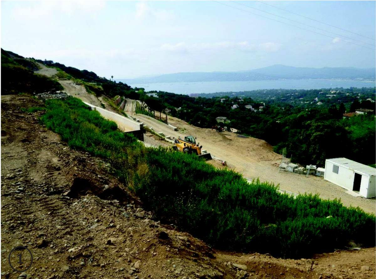
Figure 18 - Défrichage et terrassement de la zone au droit du projet des sept villas (Améten - 25/06/2015)
