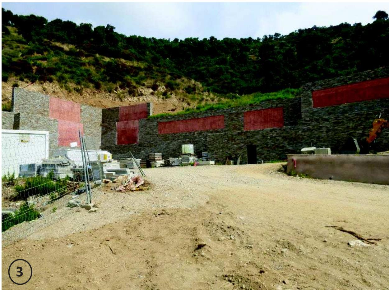
Figure 20 – Murs de soutènement (Améten – 25/06/2015)
