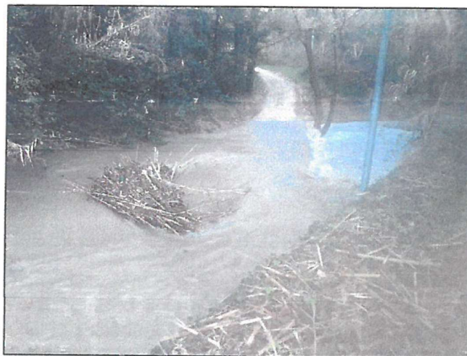
Figure 1 : Cannes de Provence emportées par le crue entraînant une sur-inondation de l'ouvrage en obstruant l'écoulement dans les buses prévues à cet effet (Crue du Grand Vallat, novembre 2019, Le Castellet).
