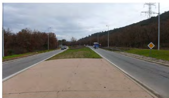
DN7 - À proximité du giratoire d'accès à la ZA - Une voie par sens
