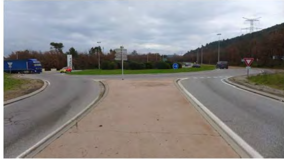
Giratoire d'accès à la ZA - Depuis la DN7 ouest
