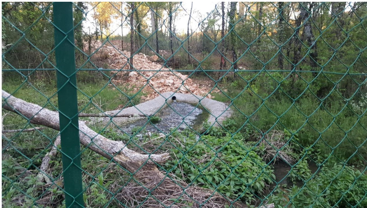
Photographie 23 : Zone de rejet de la station d'épuration
