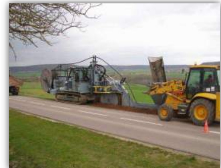
Réalisation de la tranchée
