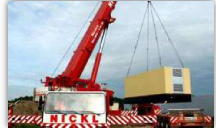
Exemple d'acheminement d'un poste de livraison préfabriqué
