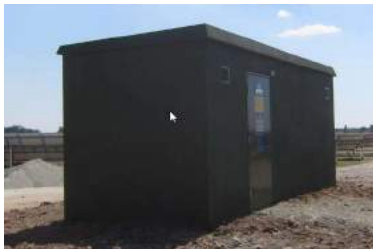
Exemple de poste transformateur
