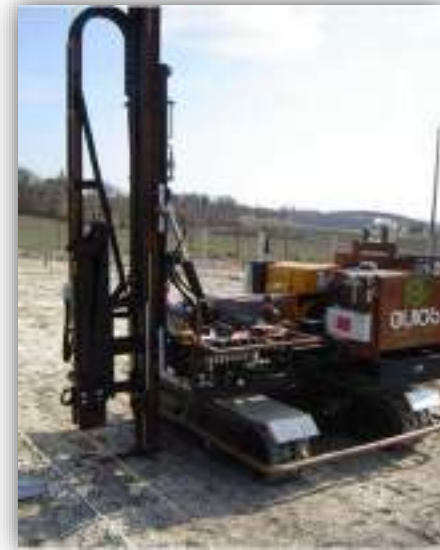
Engin de battage des pieux
