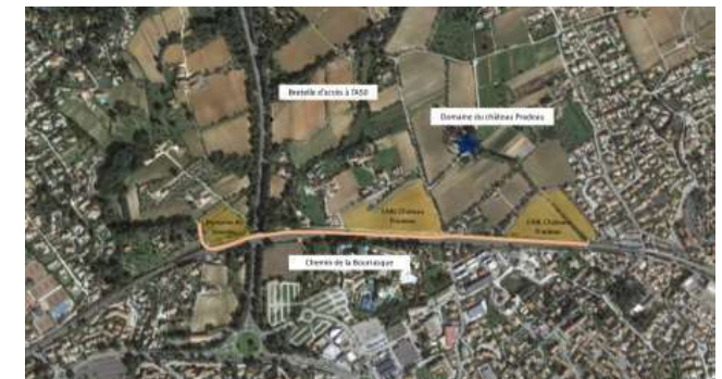
Figure 39 : Localisation des vignes AOC au nord de la voie ferrée (google earth)
