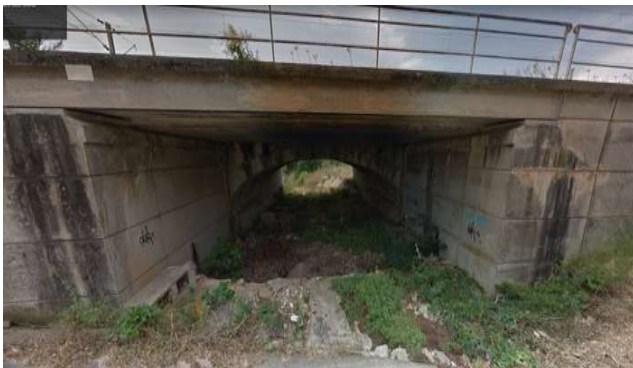
Figure 61 : Ouvrage hydraulique de la Barbarie (Google Maps)
