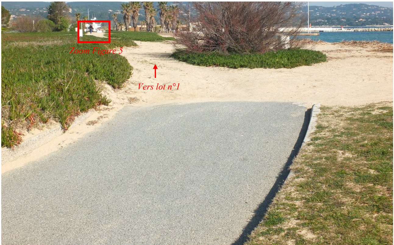
Figure 8 - Accès par le sentier « 2 » : bien que l'enrobé s'arrête à la limite du talus enherbé, le sol présente une grande rigidité
