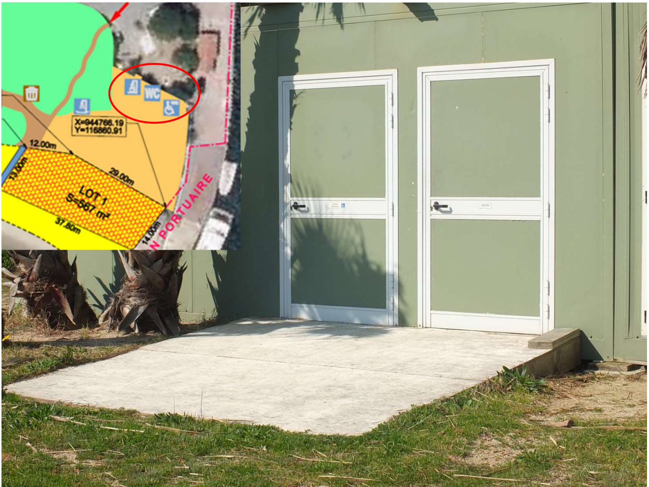
Figure 12 - WC et douche accessibles aux personnes à mobilité réduite (hors périmètre concédé)
