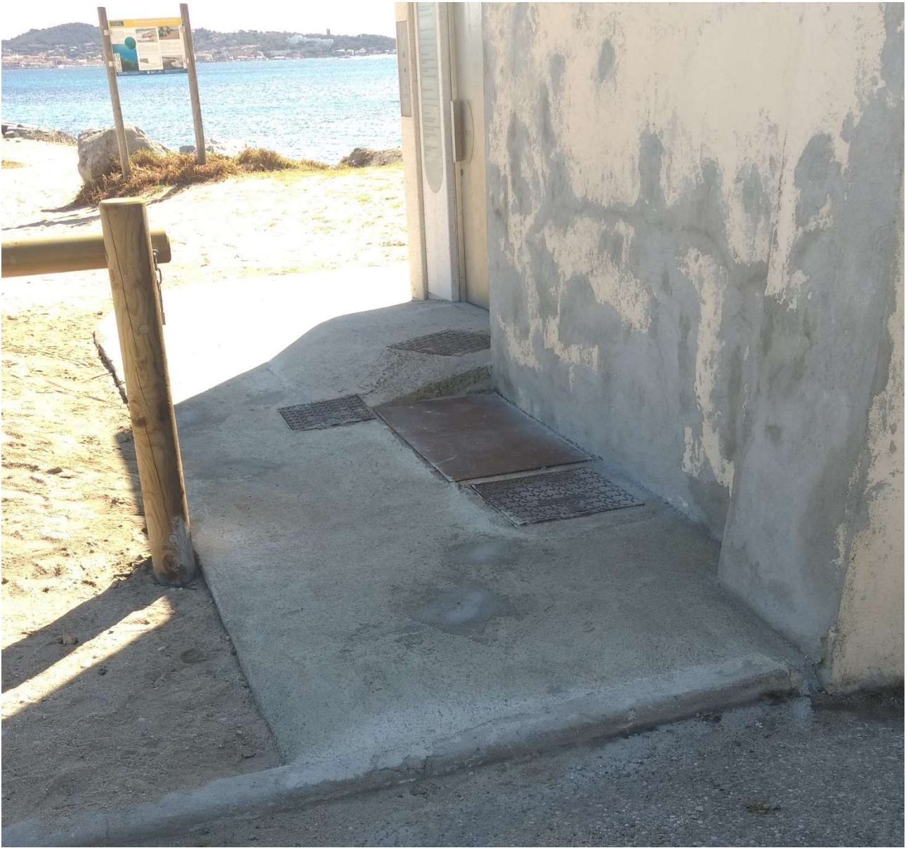
Figure 8 - Accès aménagé à la partie est (secteur 2) pour les personnes à mobilité réduite (trottoir bateau et surface béton)
