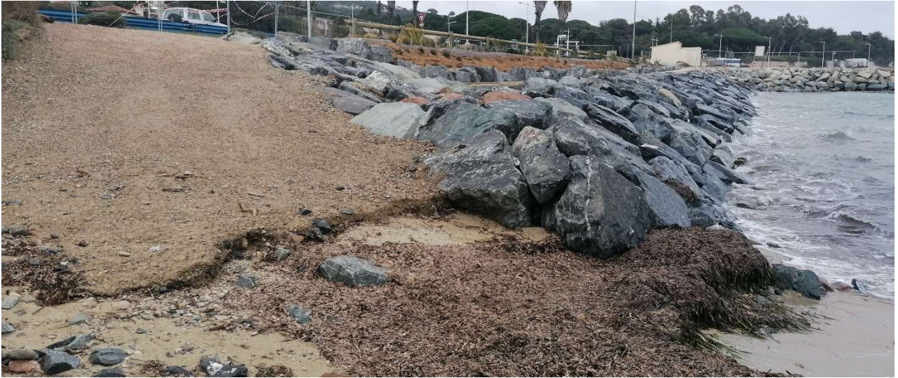
Figure 6: Accès à la partie ouest (secteur 1) : rampe en tout venant
