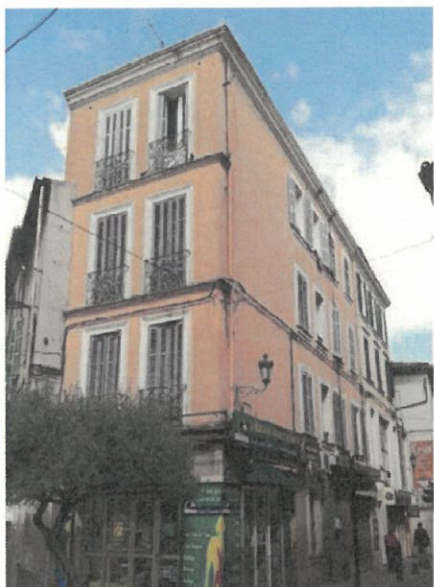
Parcelle AV 170 – 1 Rue Jules Ferry
