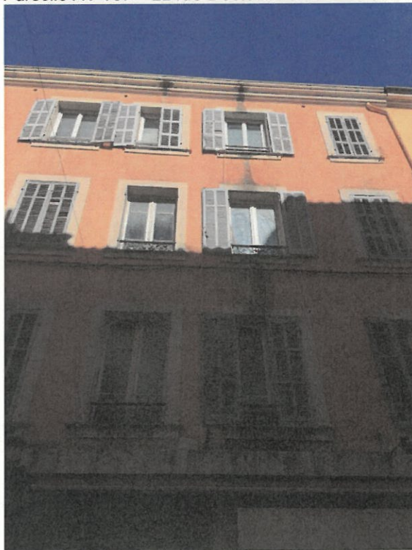
Parcelle AV 179 – 1 rue Jules Ferry
