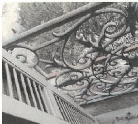
Parcelle AV 170 – 1 Rue Jules Ferry
