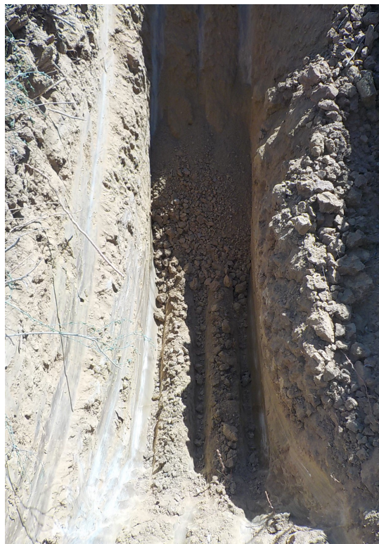
Vue du fond de fouille
