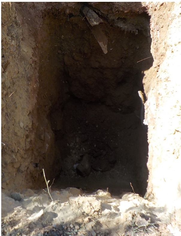
Vue générale du fond de fouille
