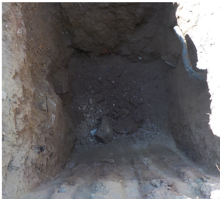
Vue du fond de fouille
