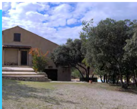
Pas de dégâts
