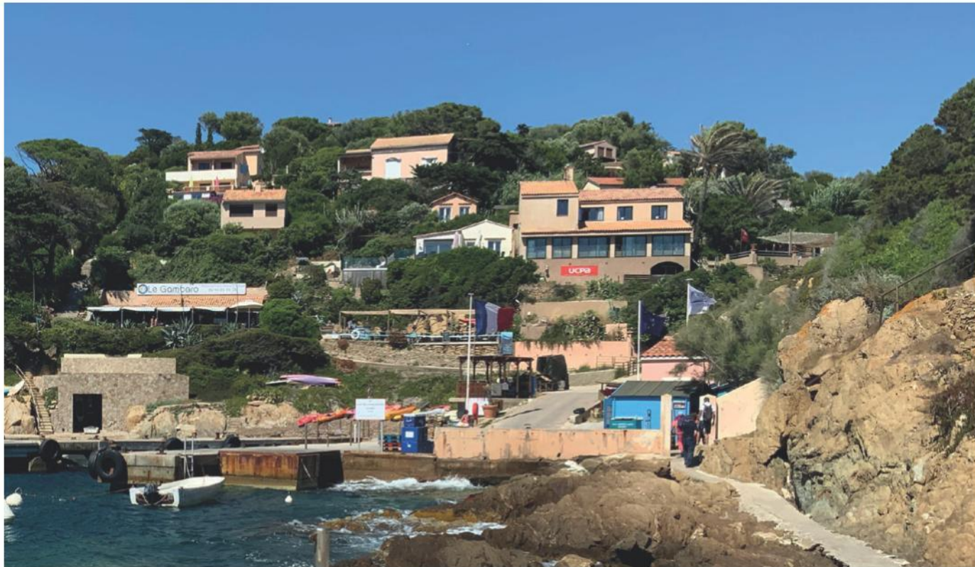
Muret et chemin dégradés vers la plage à la mer
