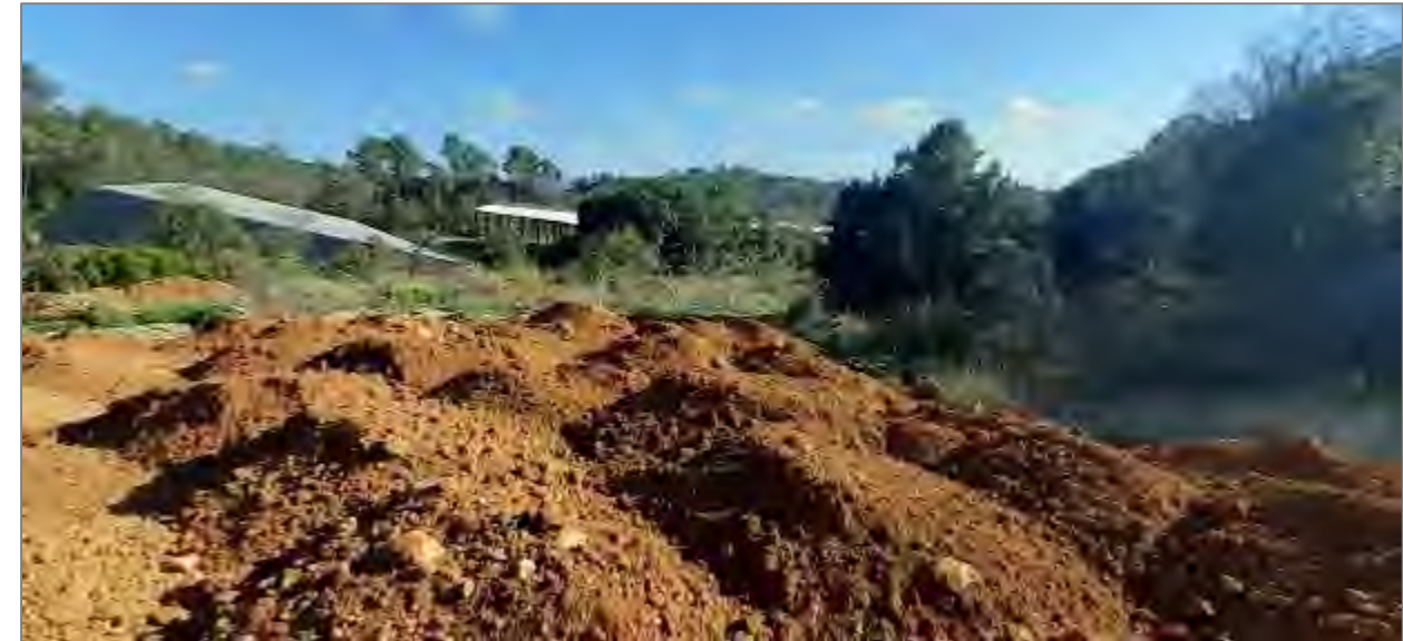
ZONE OU SERA INSTALLÉE LA BASE VIE ACCUEILLANT ACTUELLEMENT DES DÉPÔTS D'INERTES
