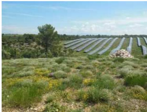
PHOTOGRAPHIE 12 : EXEMPLE DE DISTANCE INTER-RANGÉES ENTRE LES TABLES DE MODULES
