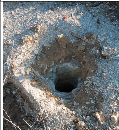
EXEMPLE DE PREFORAGE AVANT ANCRAGE DES PANNEAUX PAR PIEUX – ESPARRON-DE-PALLIERES
