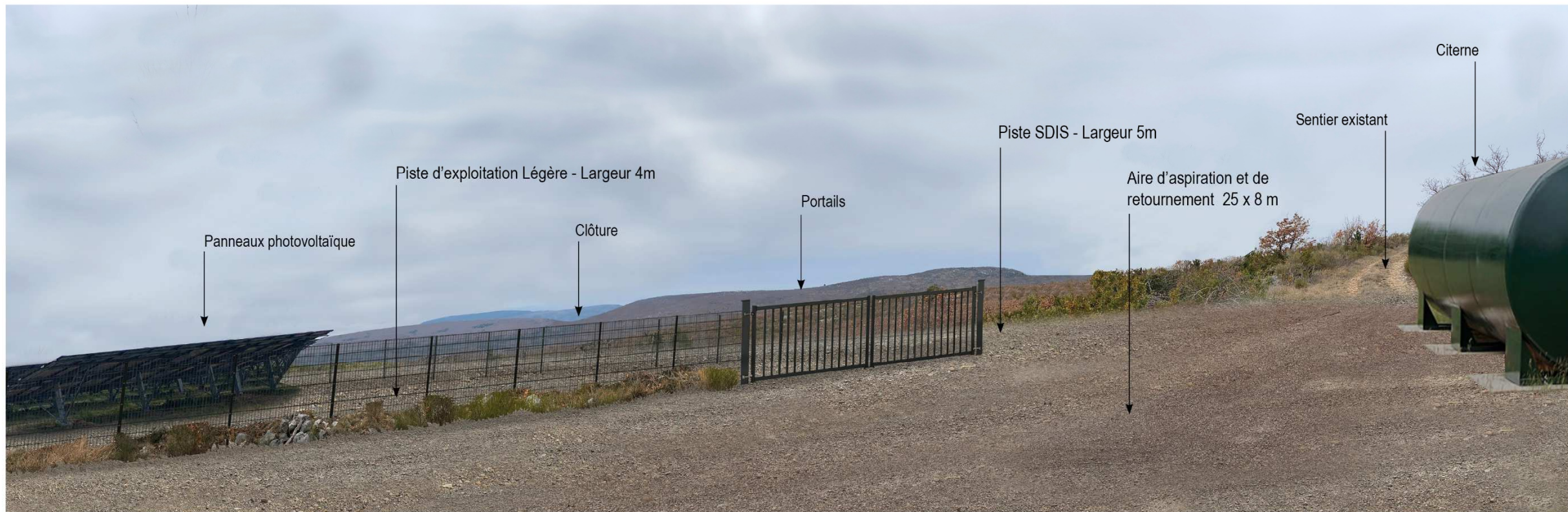
Mise en place du parc
