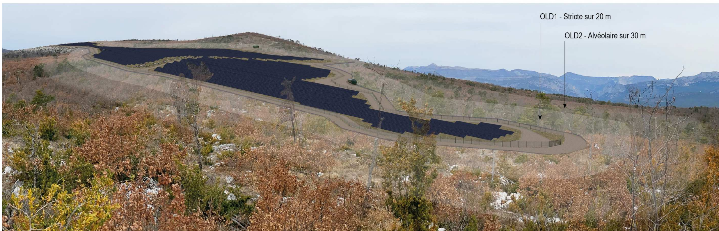
Mise en place du parc
