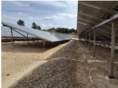
Bande empierrée (éléments fins)
