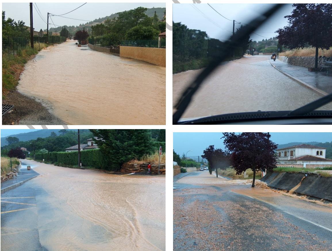
Illustration 7: Inondation du 15 juin 2010 au niveau de la RD 79 (DDTM du Var)
