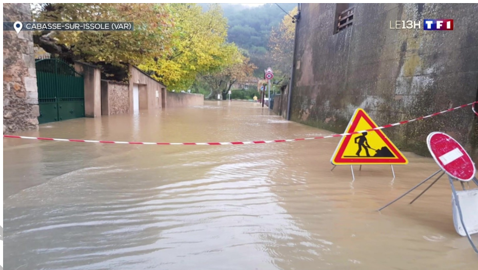
Illustration 5: Inondation au niveau de la Route du Luc en rive gauche de l'Issole (Source : JT de TF1)
