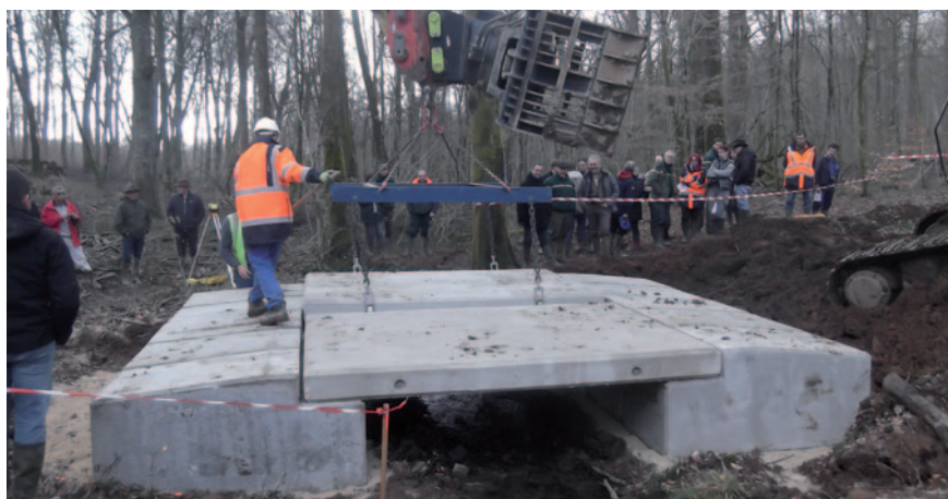
Mise en place d'un ponceau modulable en forêt de Corbenay (Haute-Saône)
