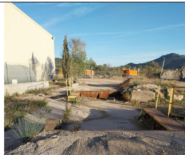
Vue 12 - Emplacement ancien et futur pont bascule
