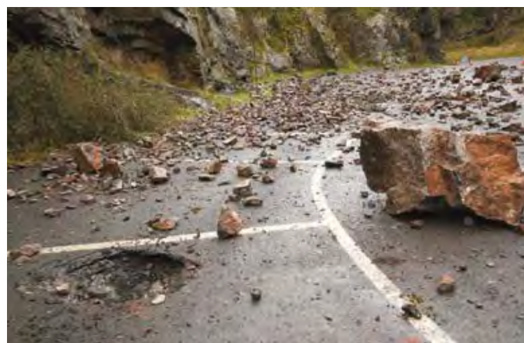
Les chutes de pierres impactent souvent les routes.
