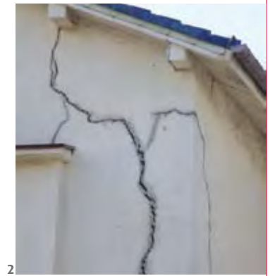
1- La végétation peut avoir un effet aggravant sur les sols argileux car ils pompent l'eau contenue dans le sous-sol.
