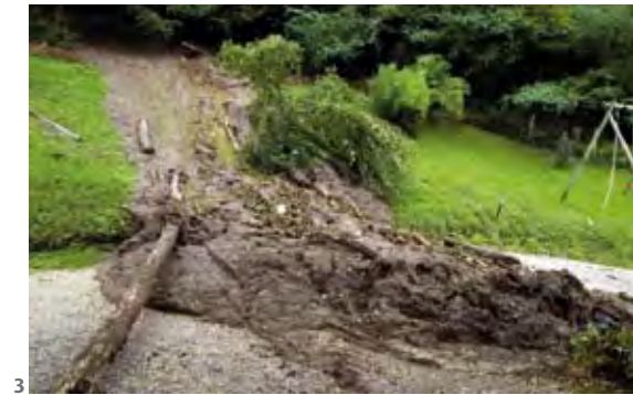
1- Effondrement d'une route suite à un mouvement de terrain. 2- Un glissement de terrain en montagne. 3- Une coulée de boue dans un jardin (Savoie).
