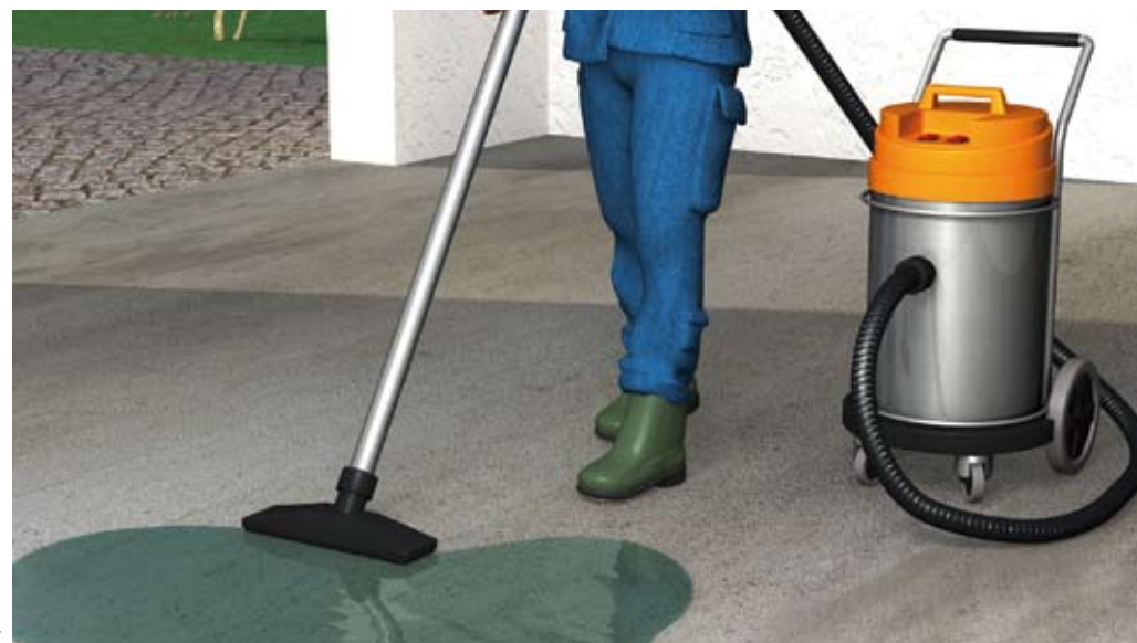
Elimination des eaux résiduelles au RDC.
