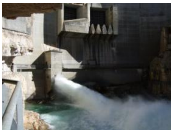
Vanne vidange de fond et évacuateurs de crue
