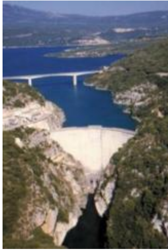
Figure 9 : Barrage de Sainte-Croix - vue de l'aval
